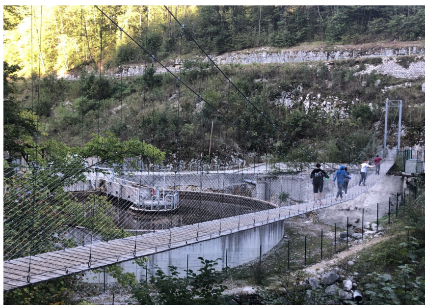
...et celui au dessus de la station d'épuration.
